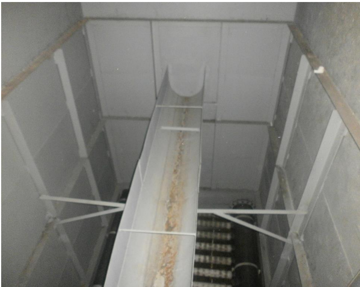
Рисунок 6. Фильтры доочистки на КОС 18 000 м 3 /сут.
