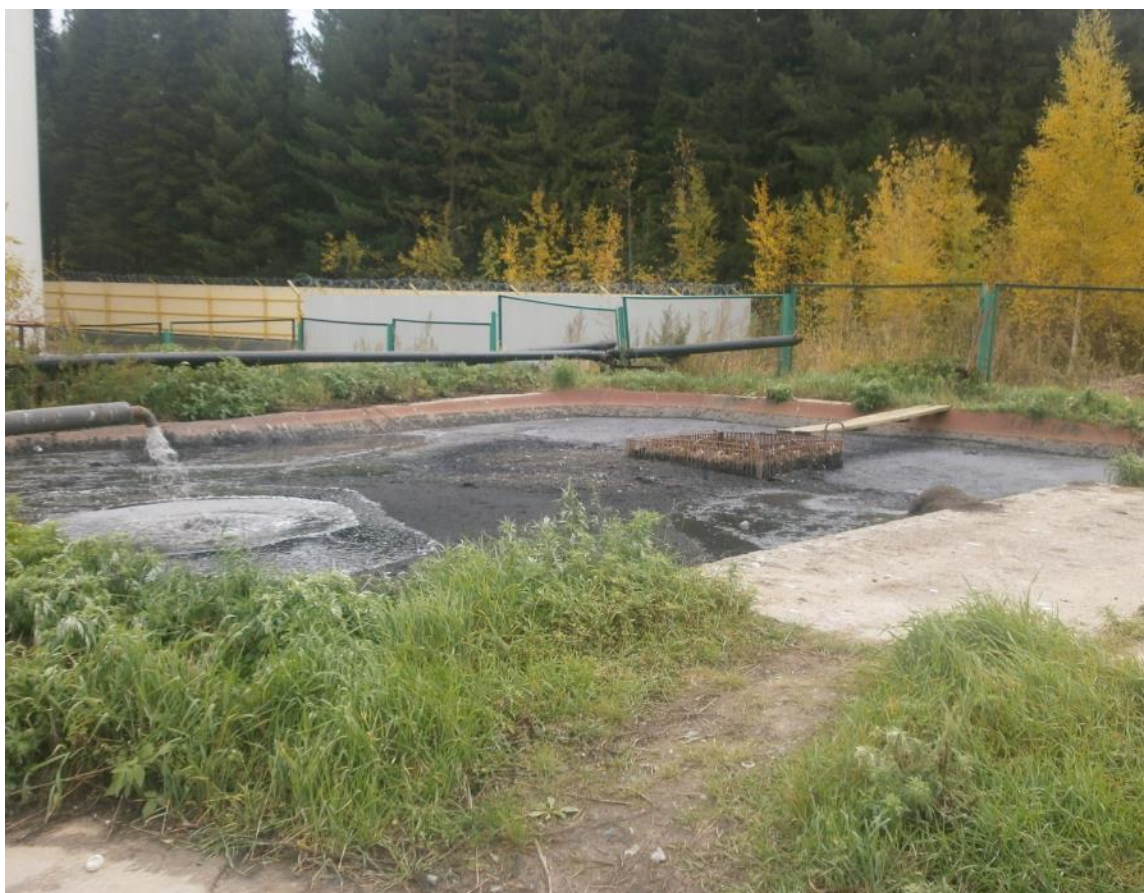
Рисунок 13. Выпуск осадка на поля компостирования на КОС 18 000 м 3 /сут.
