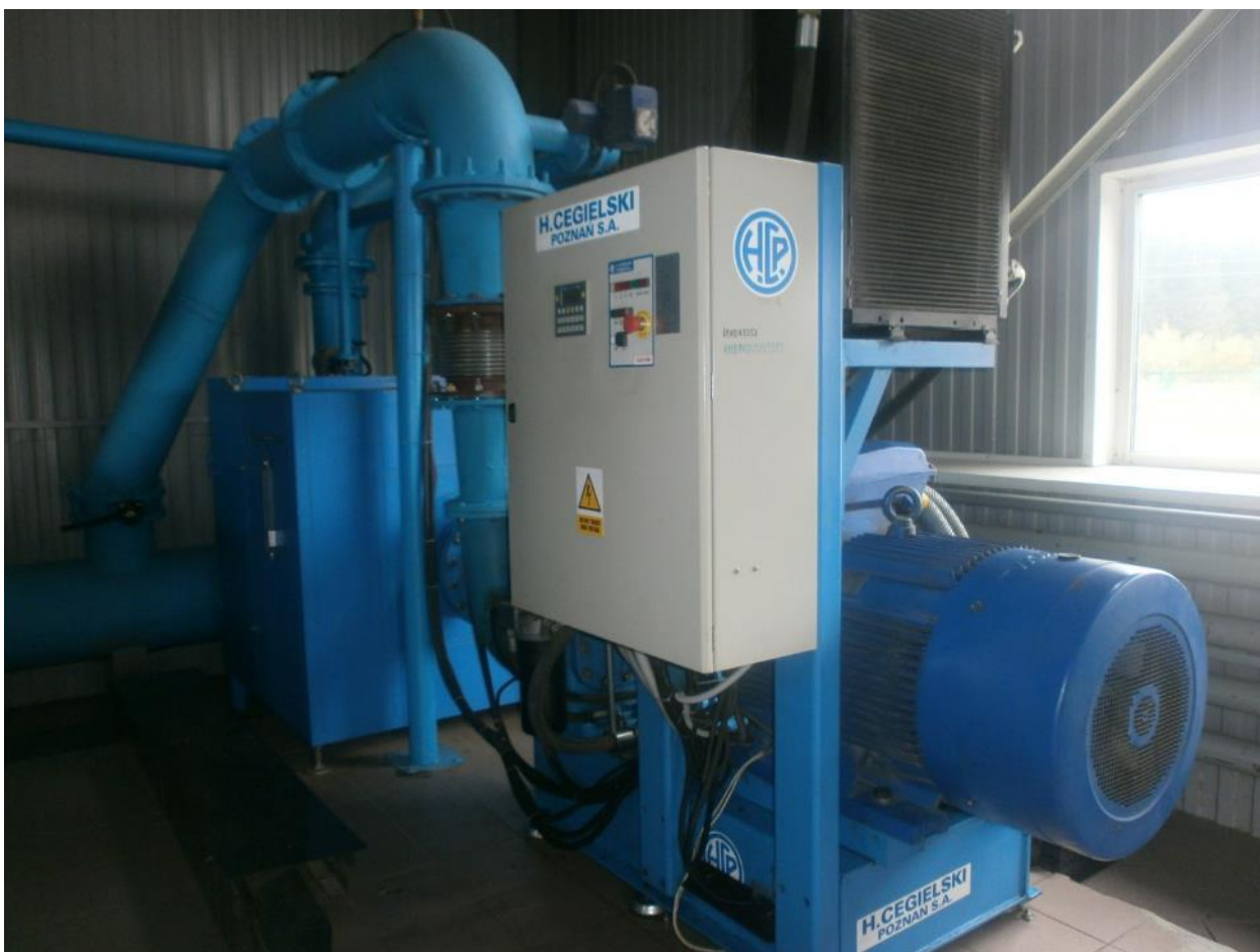
Рисунок 15. Воздуходувки на КОС 18 000 м 3 /сут.
