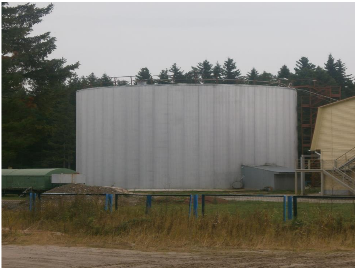
Рисунок 18. Усреднительная емкость на ГКНС
